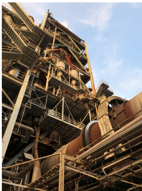
図 3 セメント製造プラント
